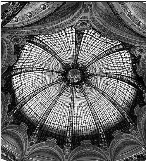
*Inspirée du style byzantin, la coupole est composée de dix faisceaux de vitraux peints enserrés dans une armature métallique sculptée.*
